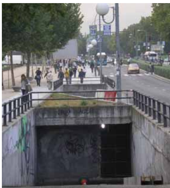
Ilustración 2. Accesos por la Avenida Complutense al aparcamiento subterráneo actualmente en obras de acondicionamiento. Fuente: foto propia.
